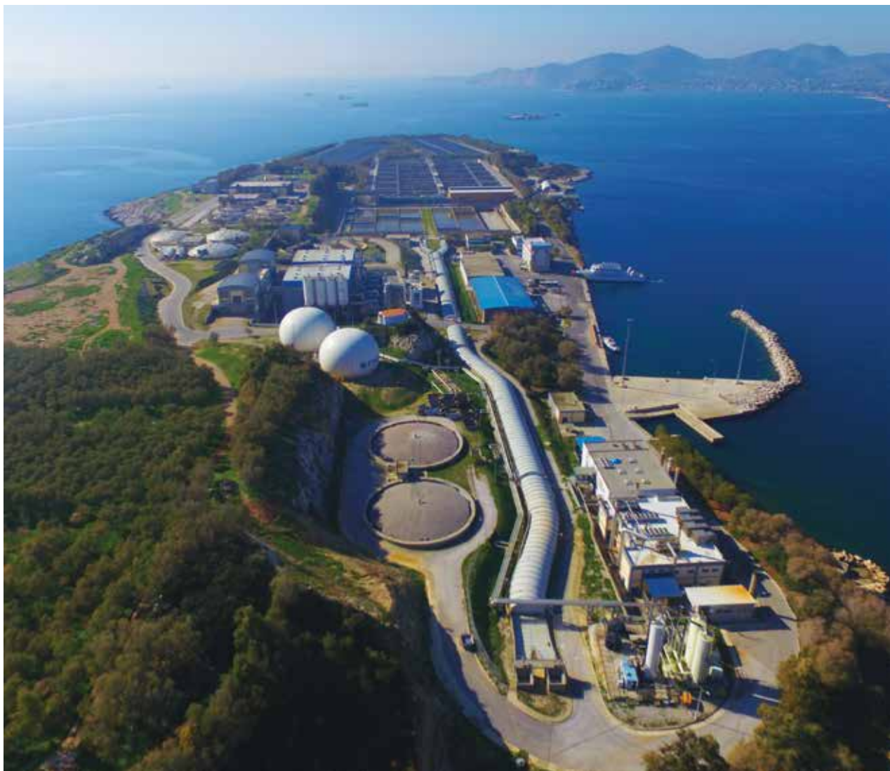
Κέντρο Επεξεργασίας Λυμάτων Ψυττάλειας
