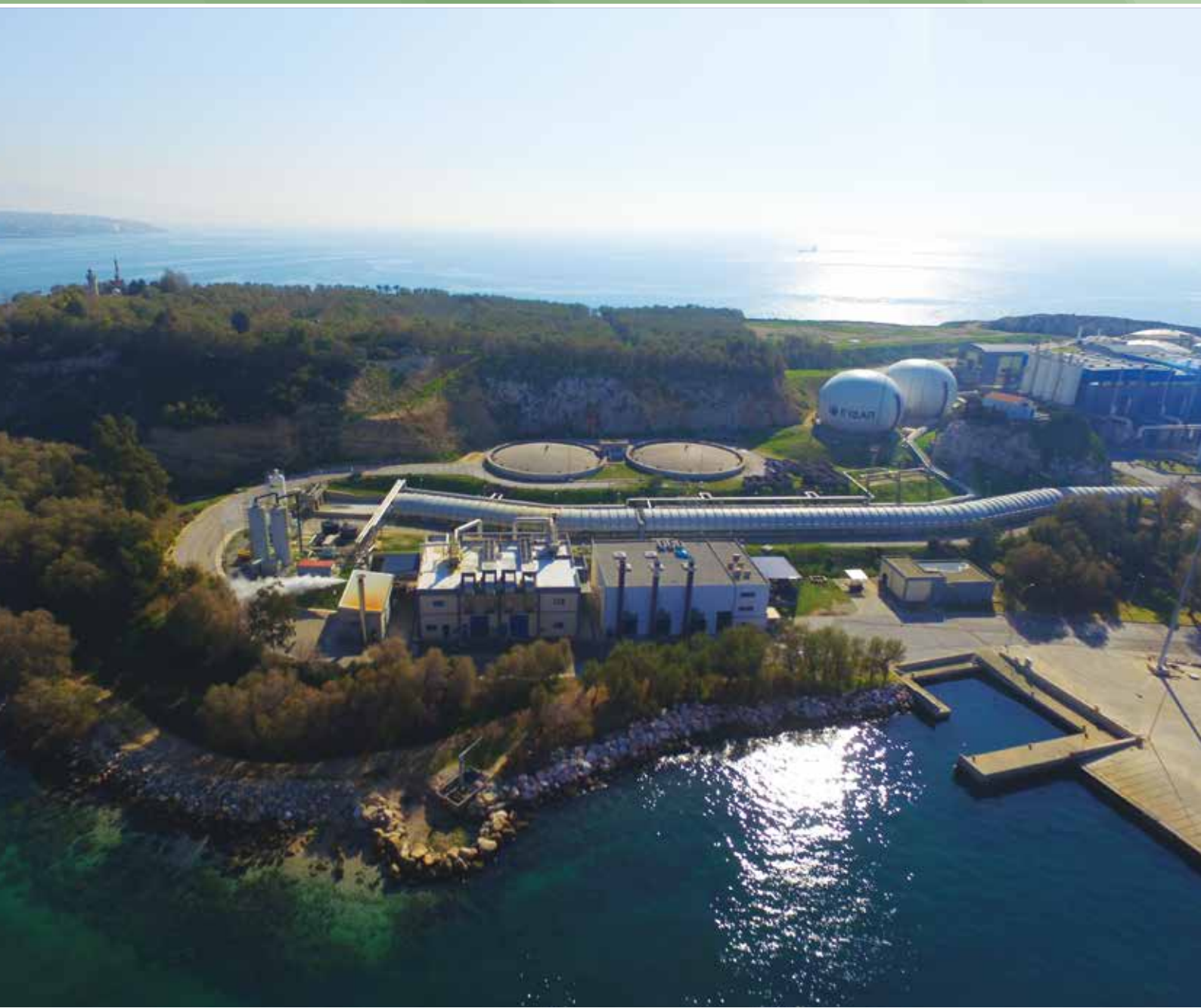
Κέντρο Επεξεργασίας Λυμάτων Ψυττάλειας
