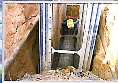
Καταβίβαση αγωγού σε σκάμμα
