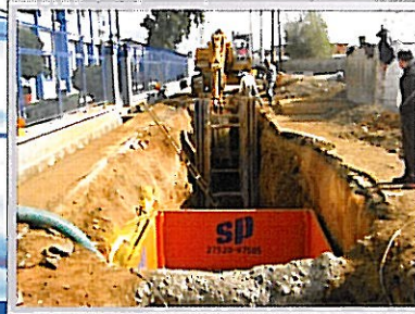
Εκκαφή αγωγού - σύνδεση με φρεάτιο επίσκεψης
