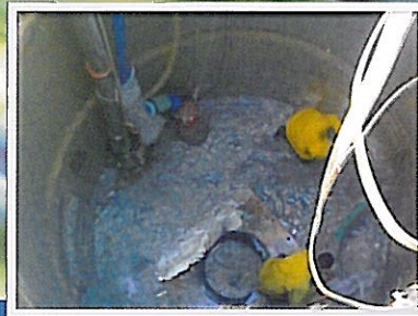
Εργασίες για τη μόνωση του φρεάτιας μικροσήραγγων
