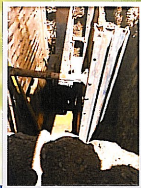
Εκκαφή σε όρυγμα για να αποκαλυφθεί η κεφαλή της μικροσήραγγας
