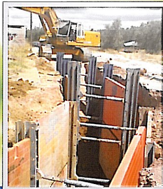
Τοποθέτηση αντιστήριξης με KRINGS
