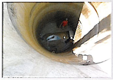
Κατασκευή ροής σε φρεάτιο μικροσήραγγων
