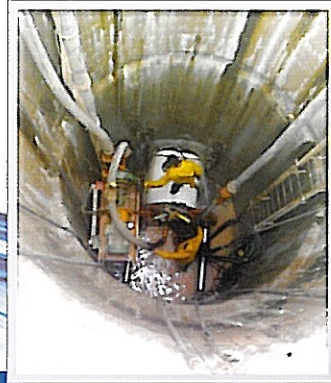
Τοποθέτηση αγωγού με τη μέθοδο της μικροσήραγγας
