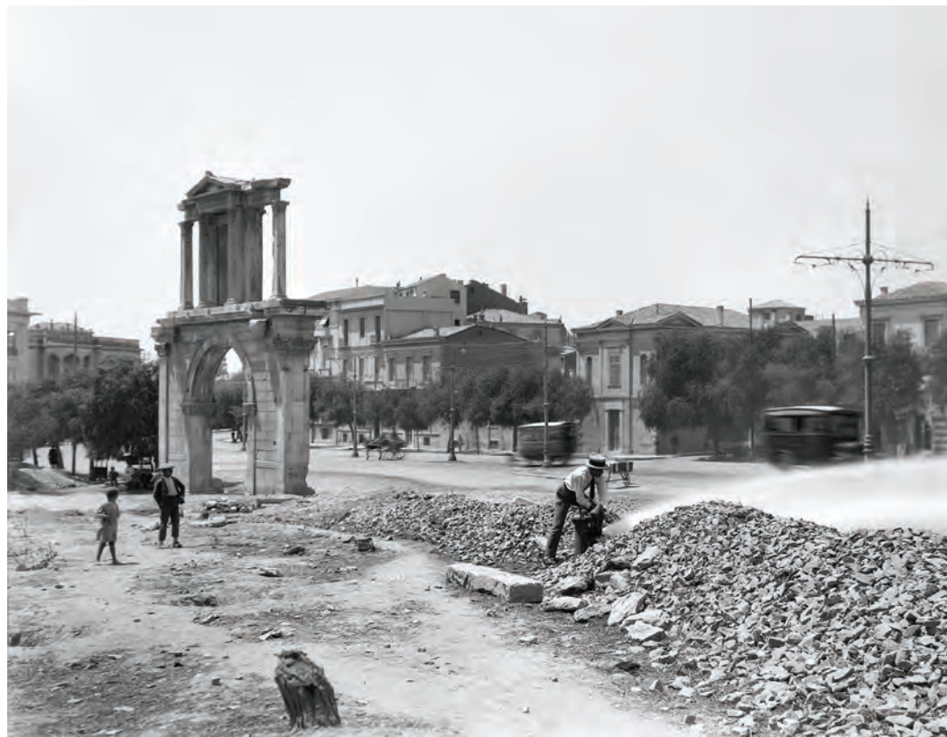
Εικ. 111 Τοποθέτηση του κεντρικού αγωγού στην Πύλη του Αδριανού.
