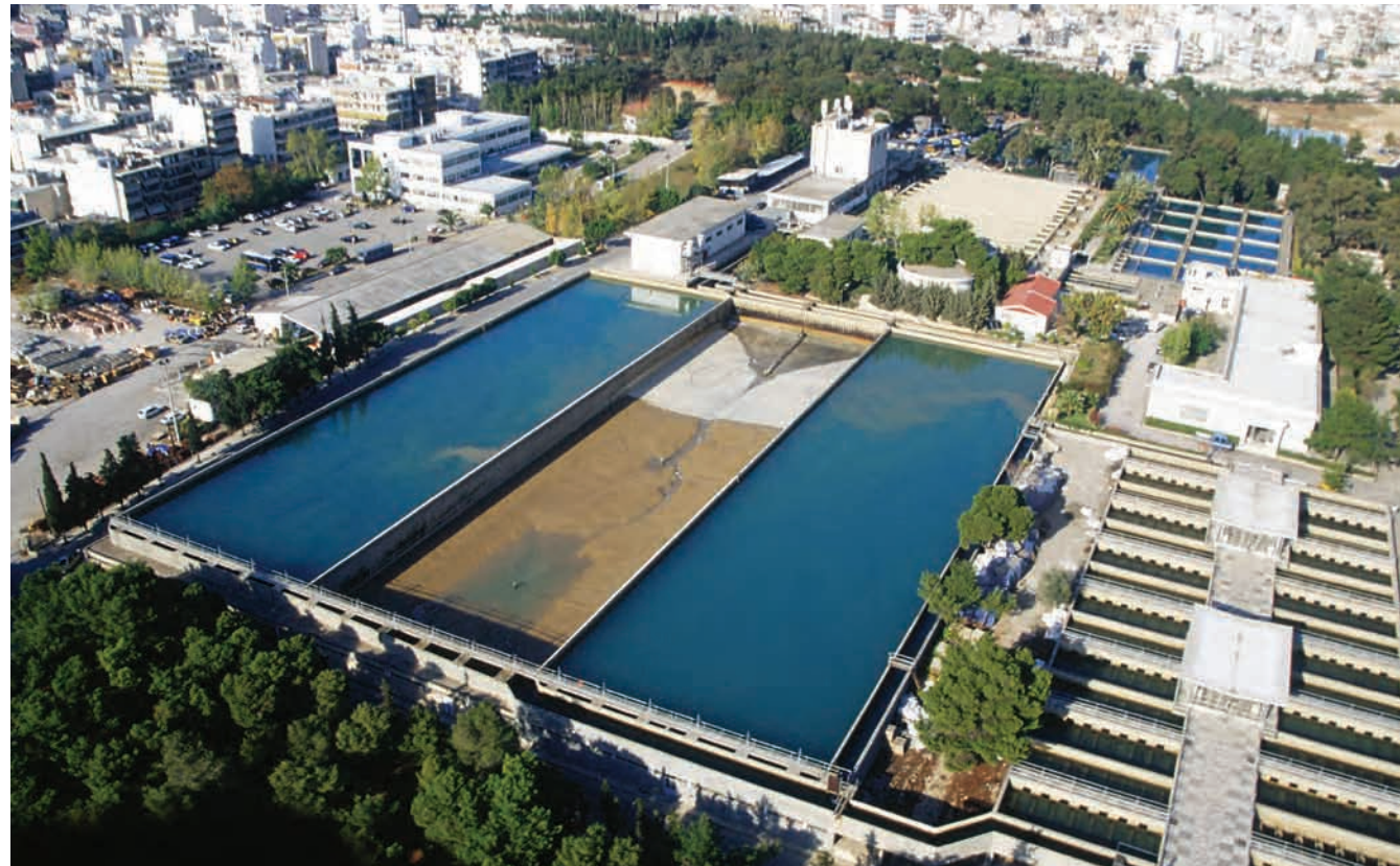
Εικ. 136 Γαλάτσι. Μονάδα επεξεργασίας νερού. Αρχείο ΕΥΔΑΠ.
