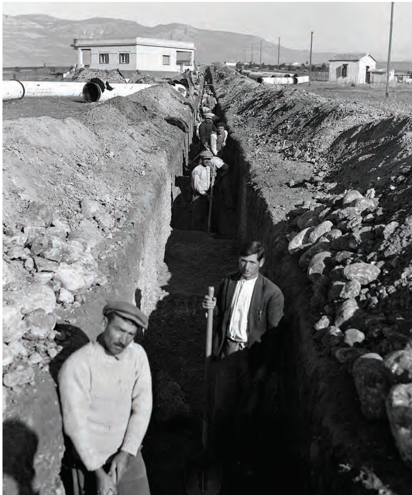
Εικ. 99 Εκσκαφή χάνδακος για την τοποθέτηση αγωγού σε προσφυγικό συνοικισμό.
