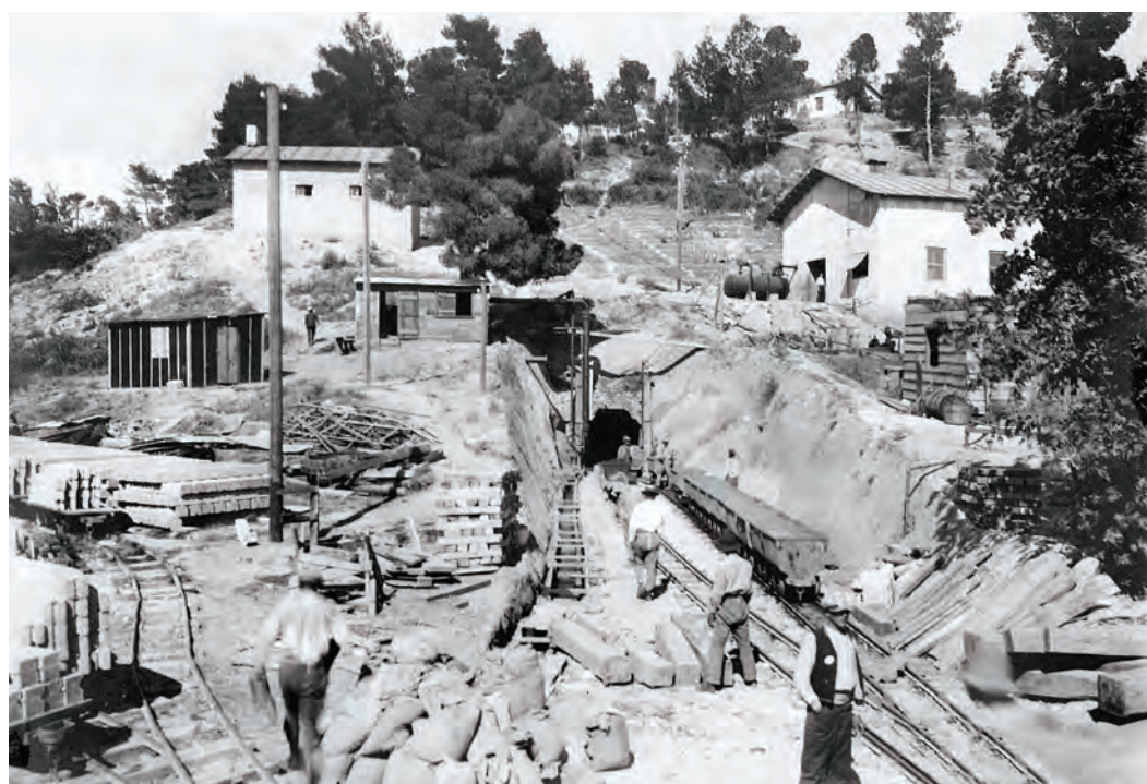
Εικ. 87 Χρονολογημένη αποτύπωση εργασιών (31.7.1929) στη σήραγγα Μπογιατίου.
