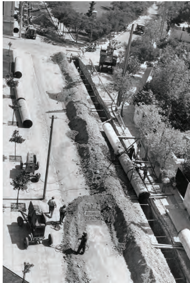
Εικ. 110 Τοποθέτηση του κεντρικού αγωγού.
