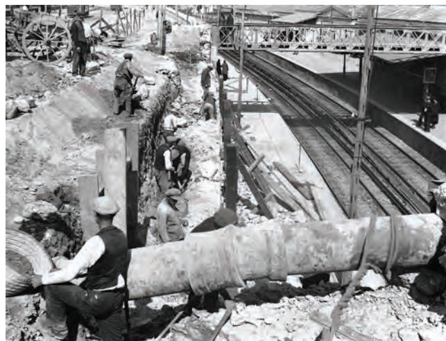
Εικ. 107 Συνάντηση του αγωγού με σιδηροδρομική γραμμή.
