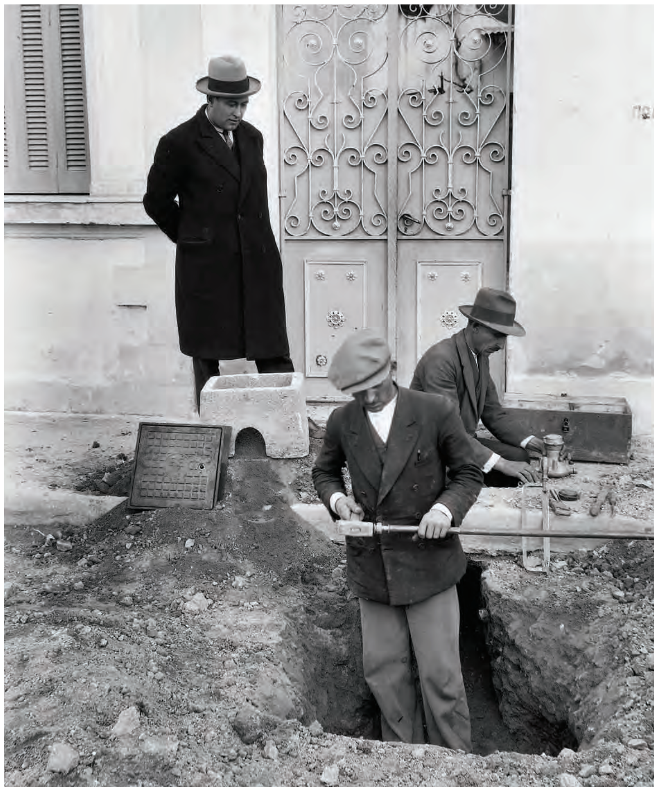
Εικ. 88 Τοποθέτηση υδρομετρητών (1927-1928). Αρχείο ΕΥΔΑΠ.
