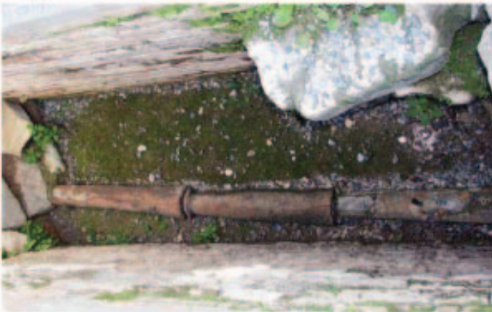
Εικόνα 2. Σωλήνες υδροδότησης: Διαστάσεις τους (πάνω) και Πραγματικό τμήμα δικτύου (κάτω)
