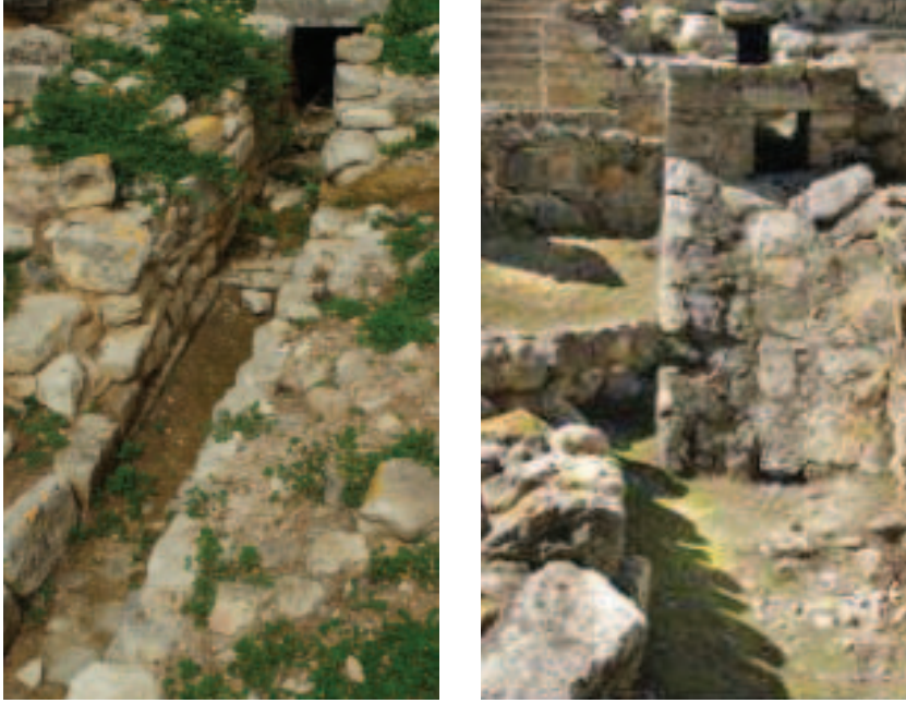
Εικόνα 4. Οι έξοδοι των κεντρικών αποχετευτικών συστημάτων των ανακτόρων: Της Φαιστού (αριστερά) και της Κνωσού (δεξιά).
