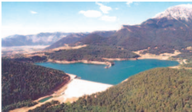
Εικόνα 13: Φράγμα Γαδουρά, Ρόδος
