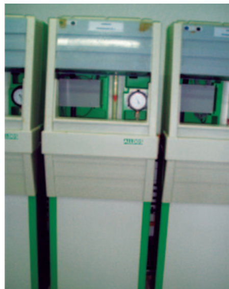
Συσκευές δοσομέτρησης αερίου χλωρίου
